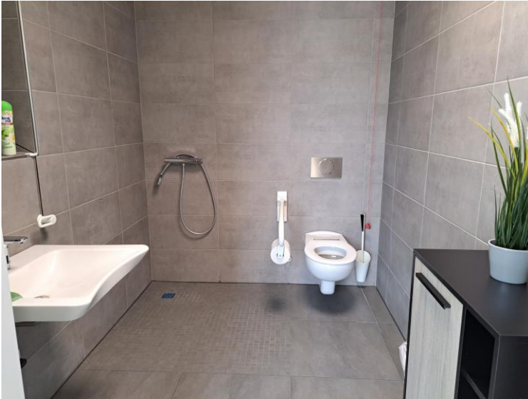
Neues Behinderten- gerechtes Personal WC
